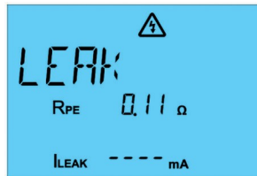
Kuva 59: Suojajohtimen virran mittaus 3-vaiheisessa laitteessa
